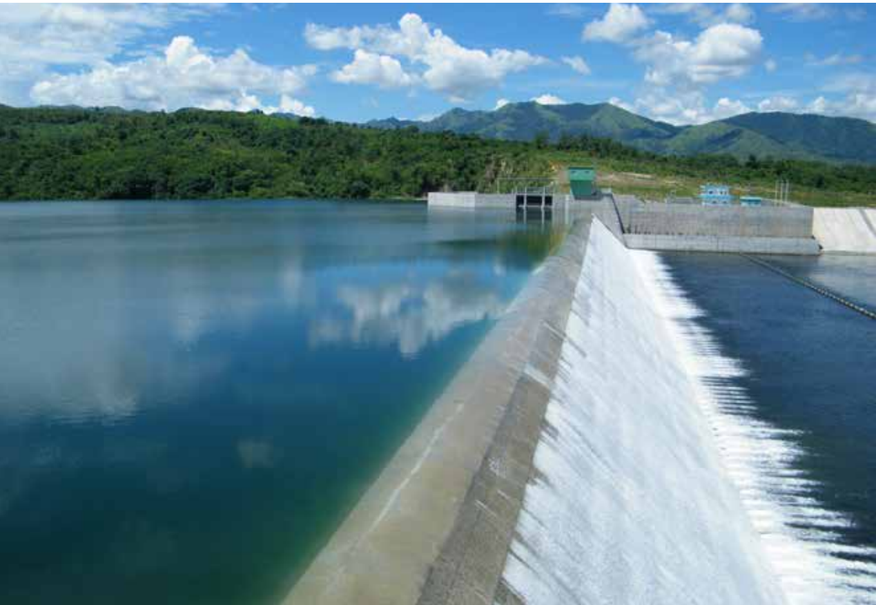
▲ 印度尼西亚杰那拉塔大坝（高 63.8 米，水库库容 2.85 亿立方米） ▼ 菲律宾阿格诺河综合灌溉工程（坝高 18 米，灌区面积 4,450 公顷）
