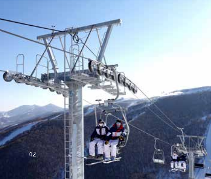
▼ 张家口崇礼县密苑云顶滑雪场雪上技巧吊椅索道（冬奥会雪上技巧索道设备）
