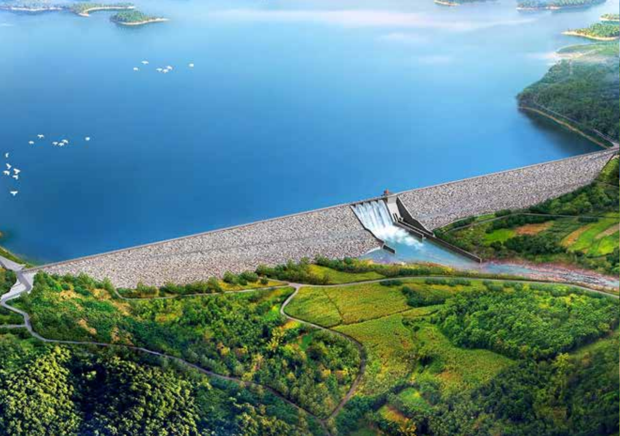
▲ 印度尼西亚杰那拉塔大坝（高 63.8 米，水库库容 2.85 亿立方米） ▼ 菲律宾阿格诺河综合灌溉工程（坝高 18 米，灌区面积 4,450 公顷）
