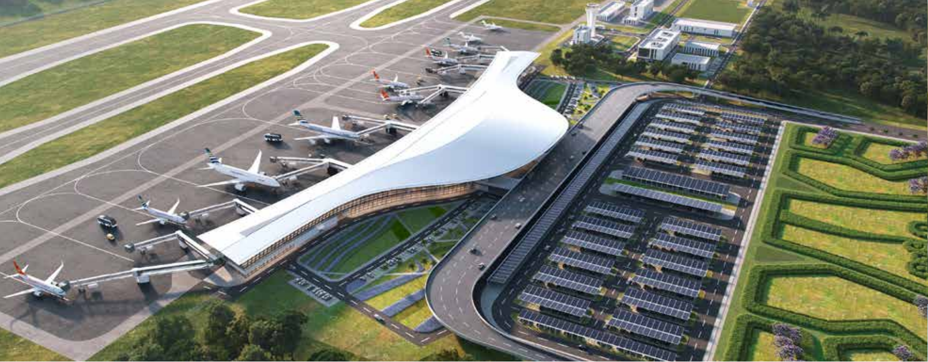
▲ 尼加拉瓜蓬塔韦特国际机场改扩建项目（中国中元设计）
