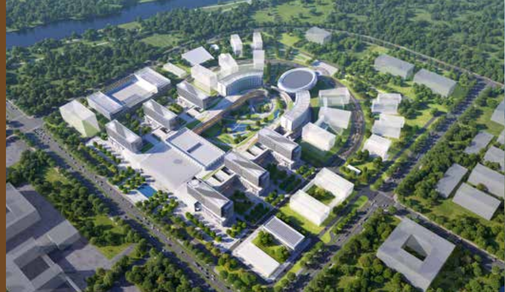
▲ 北京协和医院国家医学中心项目（雄安院区） ▼ 首都医科大学宣武医院房山区院区暨国家医学中心建设工程项目
