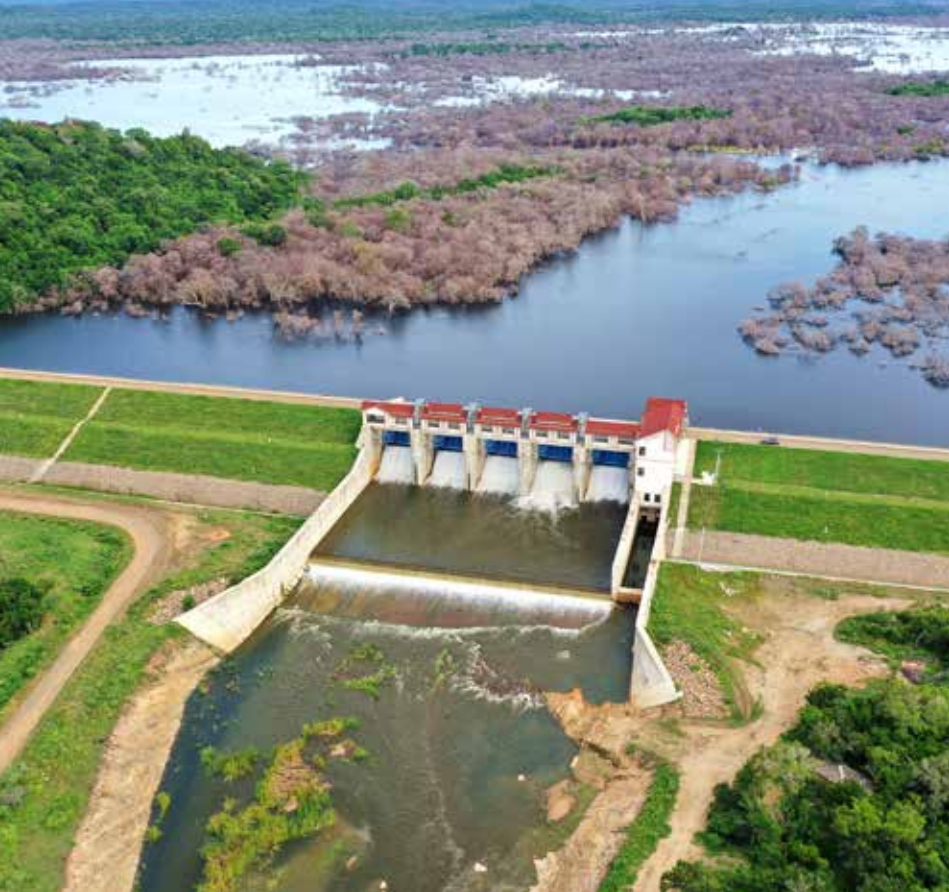
▲ 斯里兰卡延河农业灌溉（坝高 20 米，库容达 2 亿立方米） ▼ 孟加拉帕德玛水厂（日处理能力 45 万吨净水）
