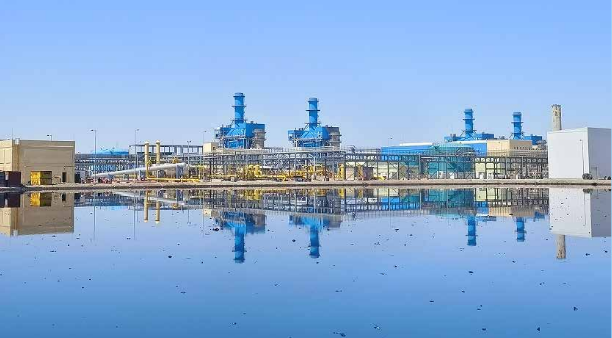
▲ 伊拉克巴士拉 650MW 燃机联合循环电站海水淡化项目
