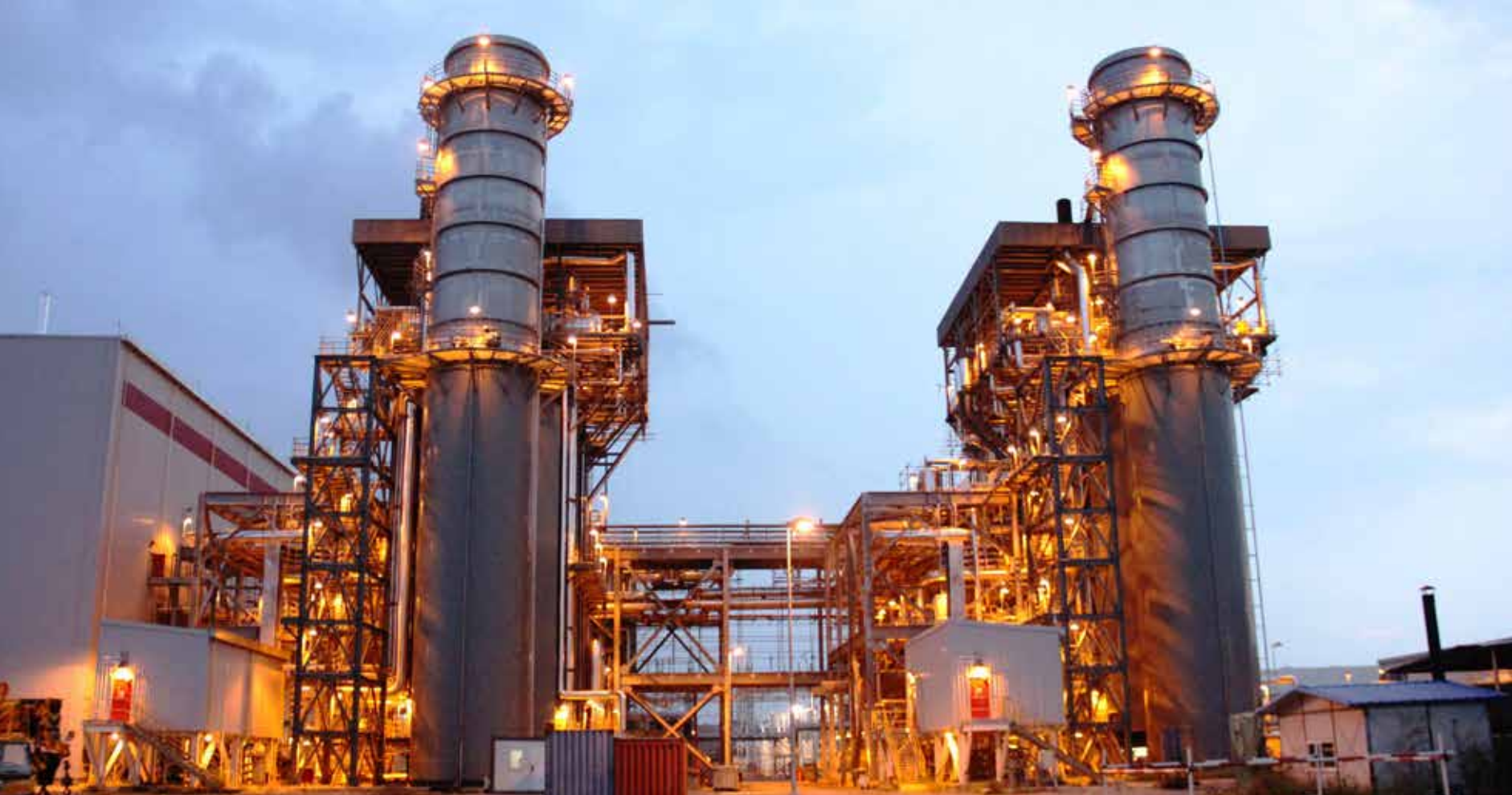
▲ 委内瑞拉比西亚联合循环电站（ISO 工况下总装机容量 597MW）
