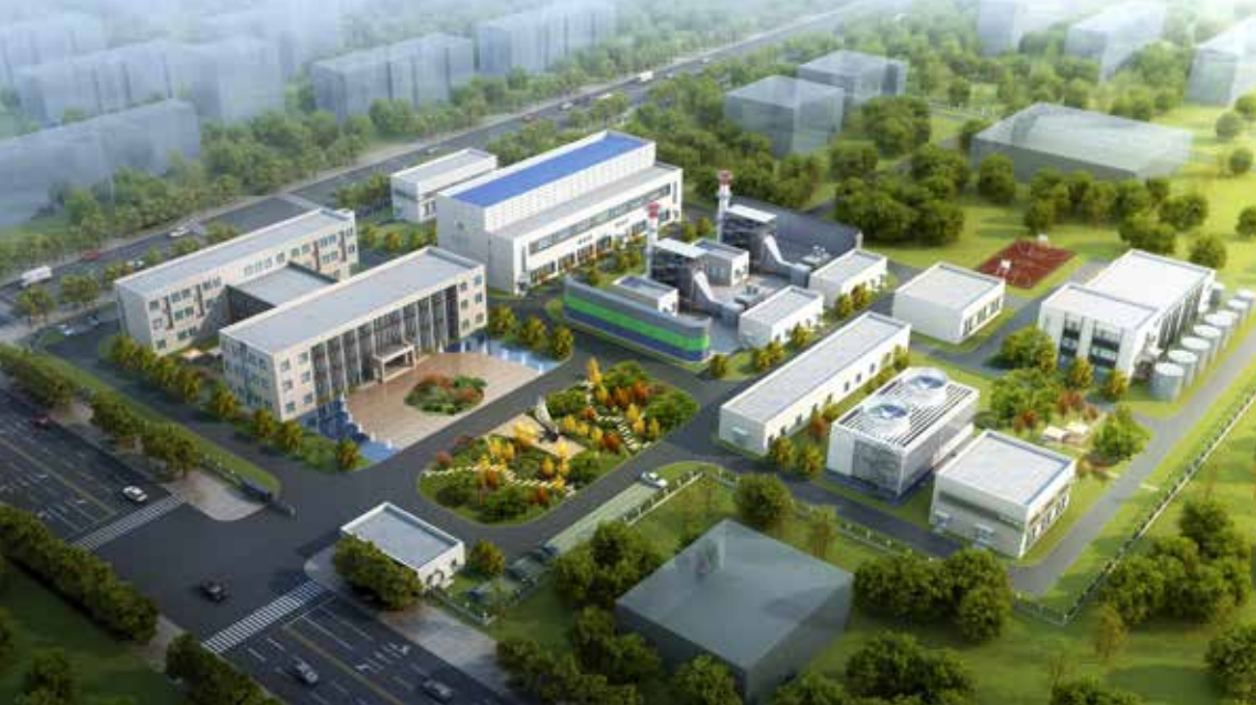
▲ 青岛高新热电有限公司燃气 - 蒸汽联合循环冷热电联产
